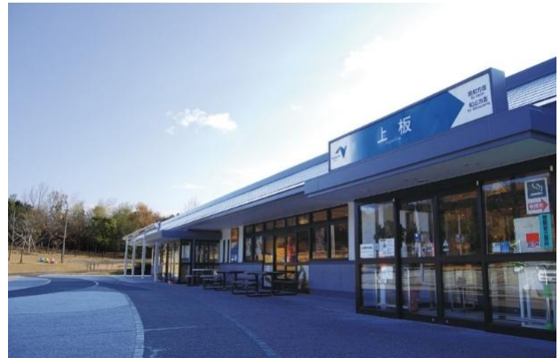
上板サービスエリア下り線
