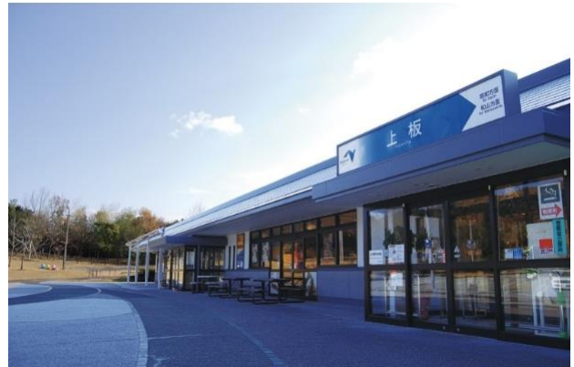
上板サービスエリア下り線
